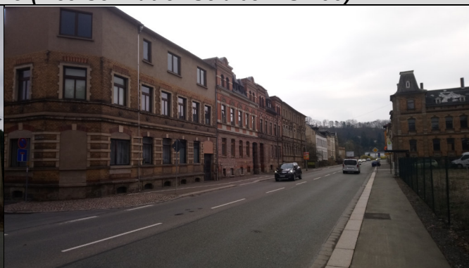
Nördliche Bebauung aus Richtung Westen
